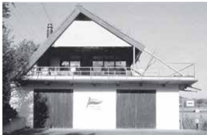
Das RCA-Bootshaus aus dem Jahr 1968 ist ein gelungenes Beispiel eines dem Rudersport dienenden Zweckbaus.
