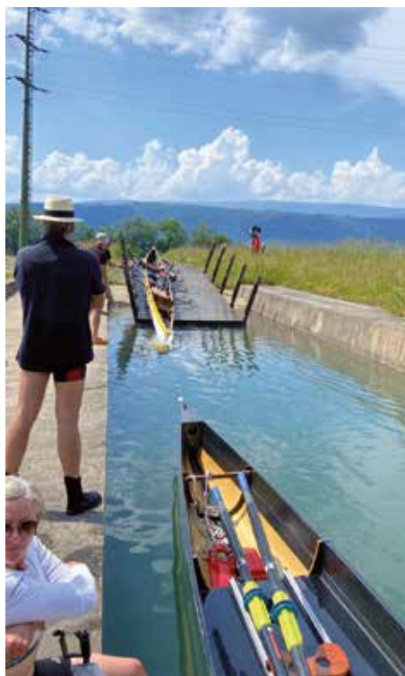
Wo die Aare sich in den Bielersee ergiesst: Boottransport beim Kraftwerk Hagneck.
