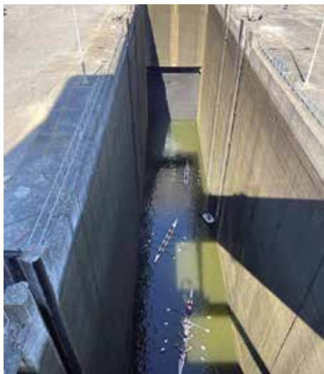
Die Schleuse Carrapatelo weist eine Höhe von 35 m auf und gehört zu den höchsten Schleusen der Welt.
